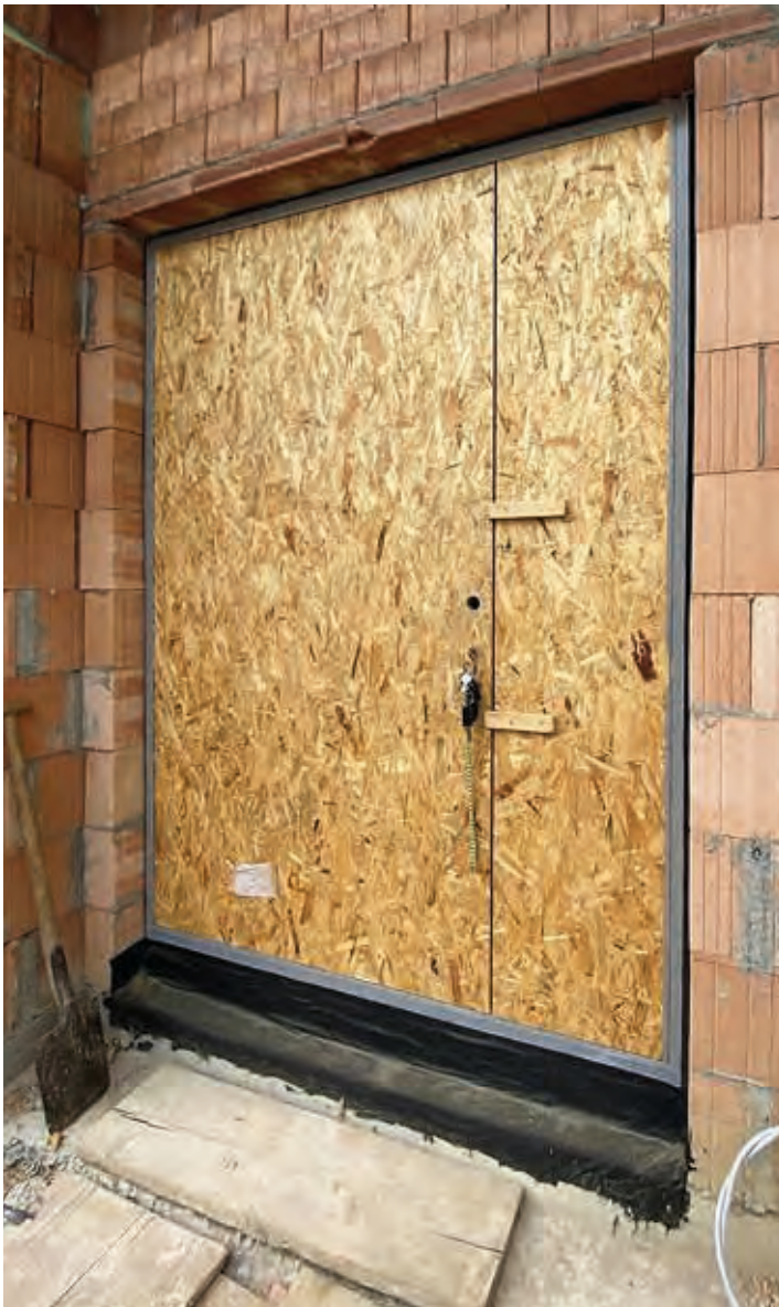
Eine Bautür mit einfachem Schloss verschließt im Neubau provisorisch den Eingang, bis die Haustür eingebaut wird. Bautüren liefert Finstral optional ab Werk.
