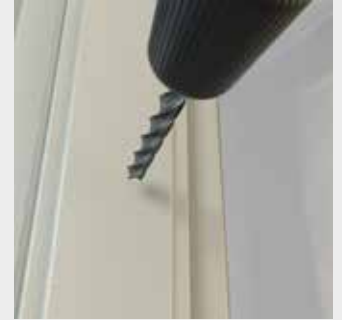
Anbohrschutz in Kombination mit abschließbarem Griff, Voraussetzung für RC 2
